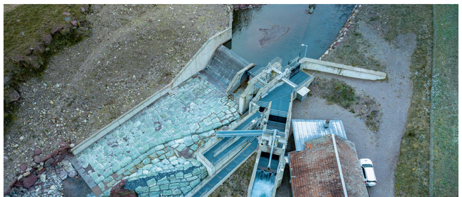
Centrale elettrica di Schils con la nuova presa d'acqua, che permette il passaggio di pesci e sedimenti.
